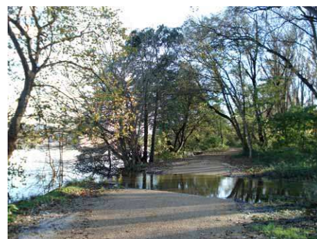
Au confluent de l'Eyrieux, la Via-Rhône est submersible
