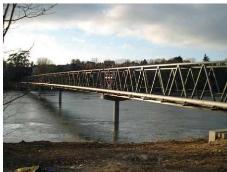
A Romans, la voie verte traverse deux fois l'Isère, sur cette passerelle, puis sur le pont vieux
