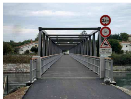
La voie verte traverse l'Isère près du barrage de la Vanelle.
