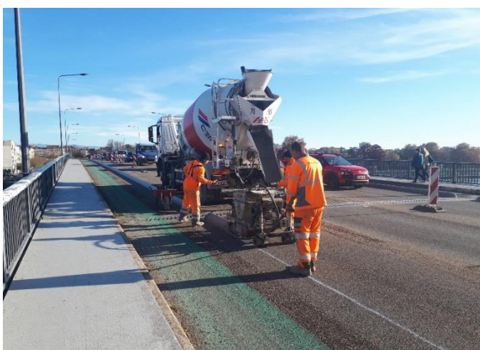
Le 29 novembre, le séparateur en béton de la piste nord est coulé.
