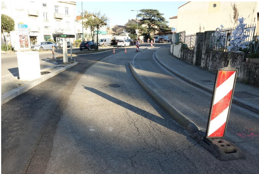
Le 23 novembre, le rail séparateur en béton a été coulé sur la piste sud du pont. Ce rail est présent dès l'amorce du virage issu de l'avenue Sadi Carnot. C'en est fini des véhicules qui avaient tendance à couper leur virage.
