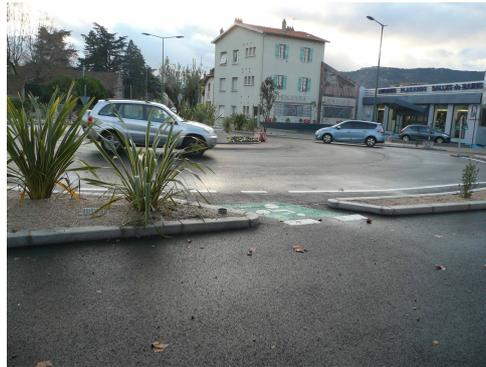
**Bateaux des passages piétons et vélos :** La bordure crée un seuil très gênant pour les personnes handicapées. Il faut une surface complètement plane pour le passage des fauteuils roulants et des vélos.
